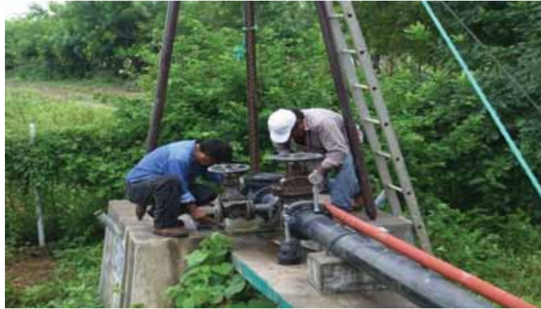
Fig. 18 Pozos profundos para el Abastecimiento de Agua Potable
