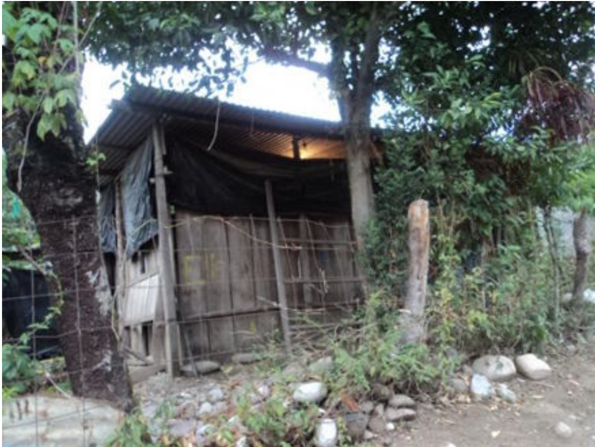
Vivienda a base de tablas en el Municipio de San Felipe Usila
